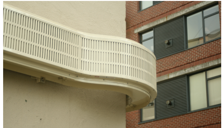
Actual SuperiorBus™ system install
